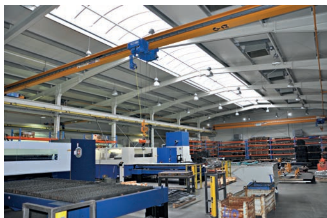
Interiér výrobní haly
