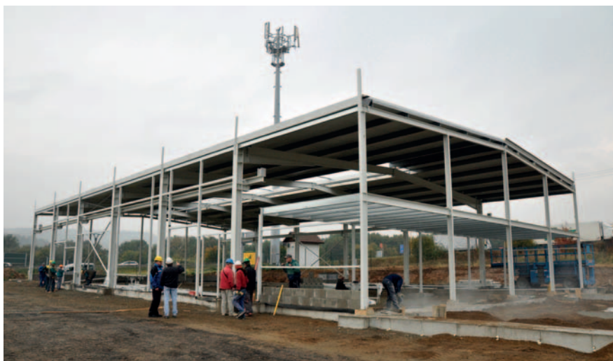
Ocelová konstrukce haly Hutira
