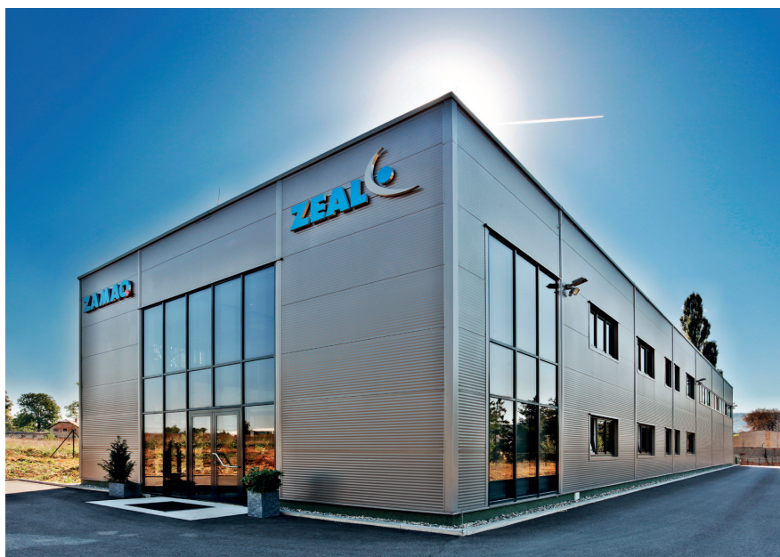
Montovaná hala Zamaq Hranice
