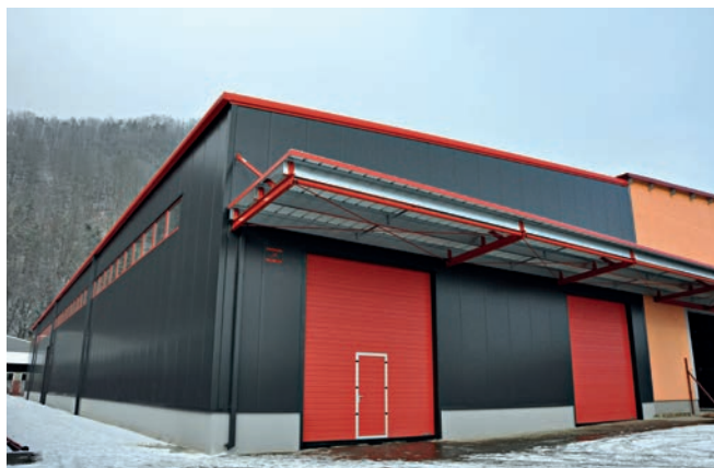
Skladová hala 17×64, Povážské Podhradie, SK
