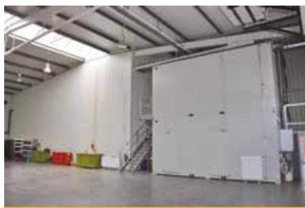
Interiér haly - dělicí příčka z trapézového plechu vč. kanceláří technika
