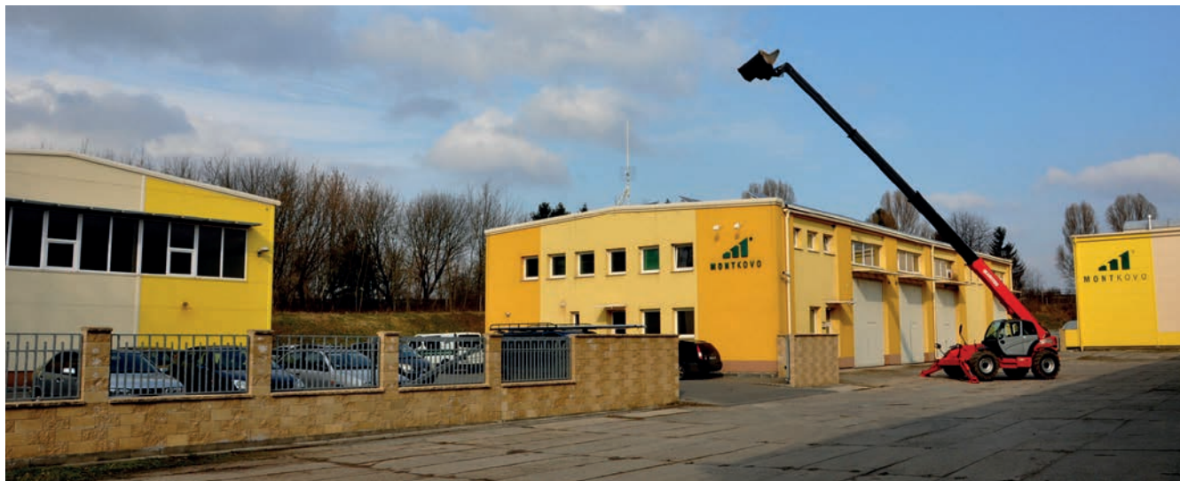
Výrobní areál MONT-KOVO, Hulín
